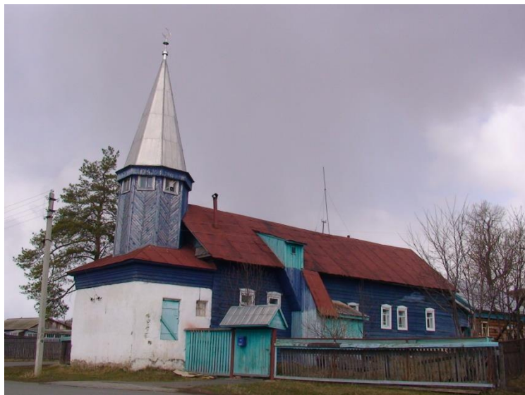
Мечеть, д. Новый Бугалыш (Красноуфимский район)
